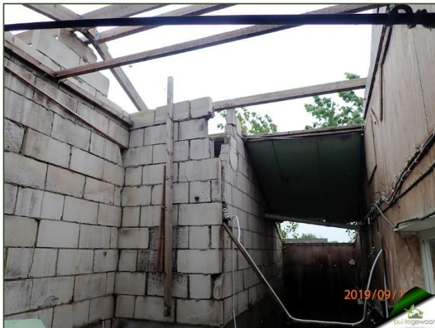
Figuur 7. Zuidelijke kop van opstal 2
