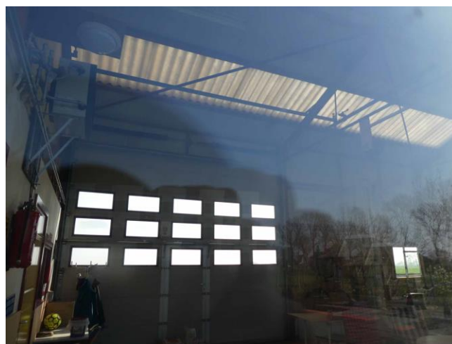
Figuur 13: Binnenzijde van de loods met de lichtplaten
