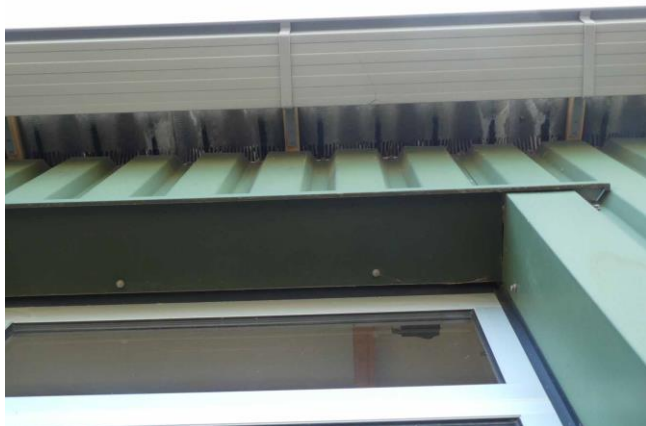
Figuur 12: Detail wand van de loods
