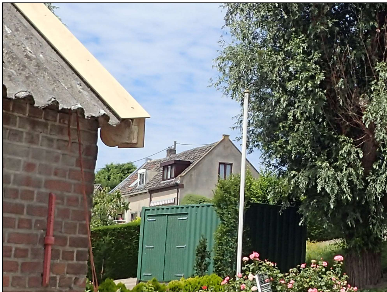
Middelblok 103 (zij en achtergevel)
