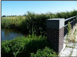
Figuur 2. Westzijde onderzoekslocatie, toegang via een brug over watergang met brede rietoever.
