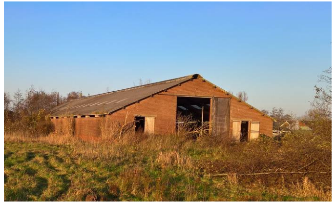
Foto 2: ligboxenstal, zuidelijk gedeelte locatie
