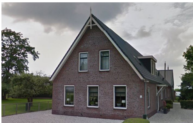
Woningen in de omgeving, klassieke massaopbouw en materiaalgebruik
