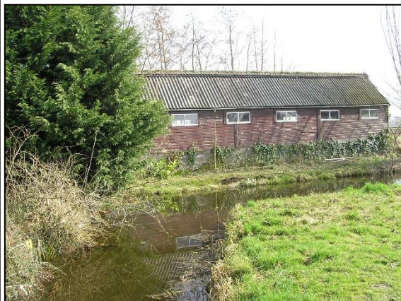
Bestaand bijgebouw met watergang welke de percelen scheidt van elkaar.
