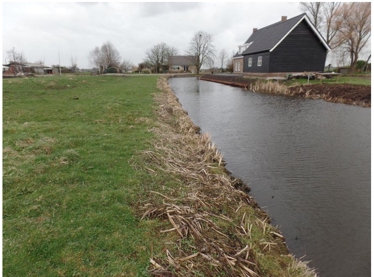
Figuur 9: Oostelijke oever perceel 3
