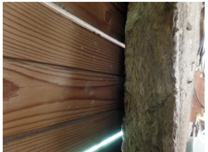
Figuur 10: Bouwkundige inspectie van de gevel van de loods (links) en kieren tussen het latwerk en de isolatielaag rechts).
