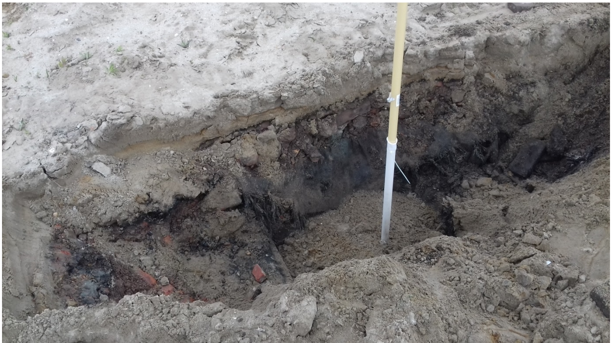
Foto 8, Sleuf (en peilbuis) 202
