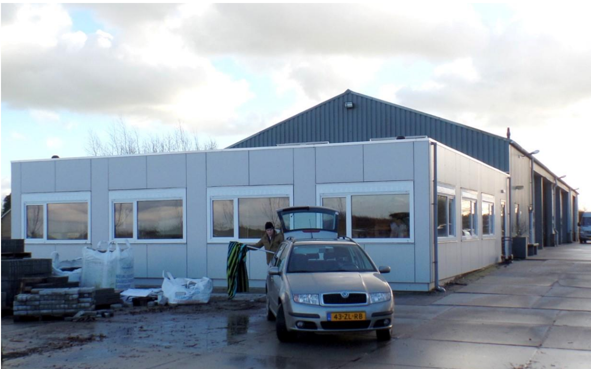
Figuur 8: (boven) de af te breken loods en figuur 9 (onder): de daaraan aangebouwde kantine.
