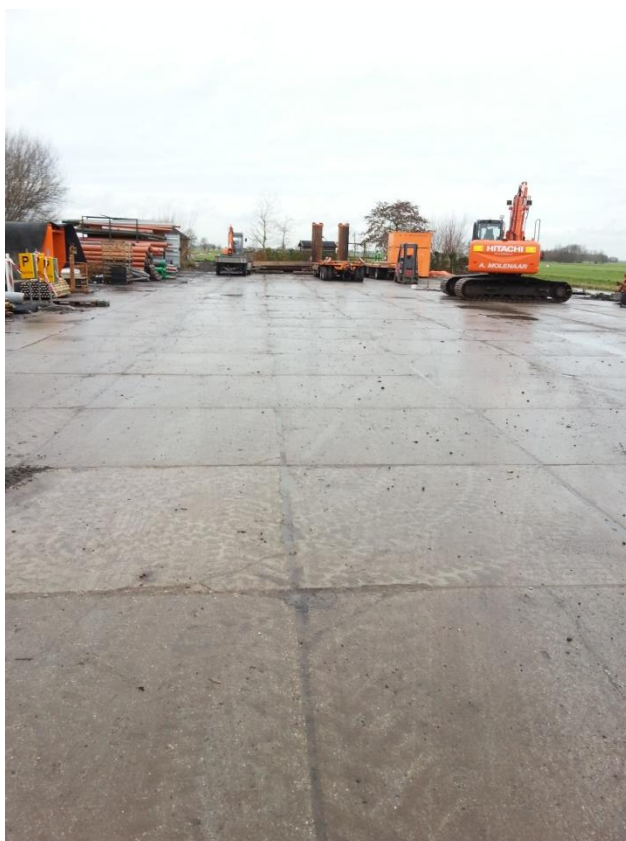
Fig. 1 overzicht van het plangebied, richting het noorden
