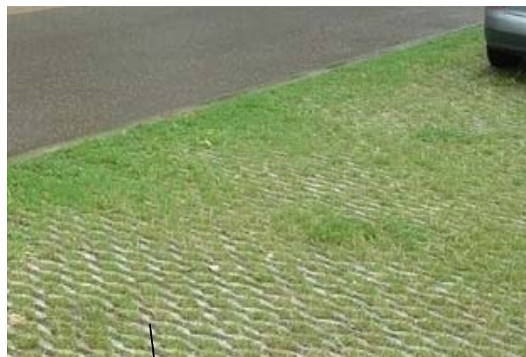
Grasbetontegels voor stabiel parkeren in de grasberm
