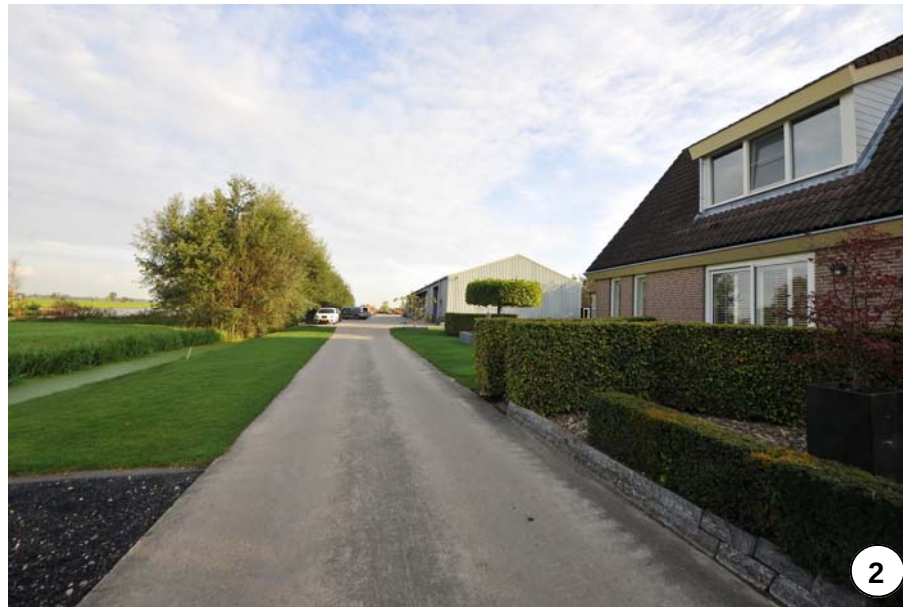
Zicht vanaf oprit op Tussenlanen 20b met te slopen bedrijfsgebouwen
