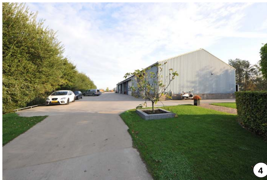
Bedrijfsloods op achterzijde perceel, te slopen
