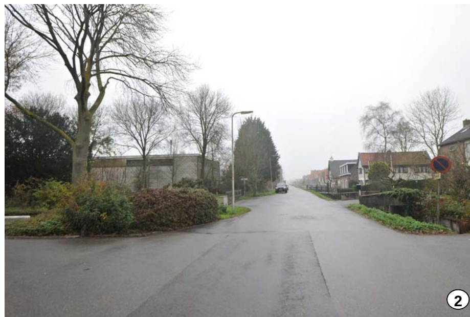
Dijklaan met links het begin van Dijklaan 87 met een grijze bedrijfshal (te slopen)
