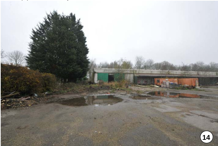
Verpauperde gebouwen op het perceel
