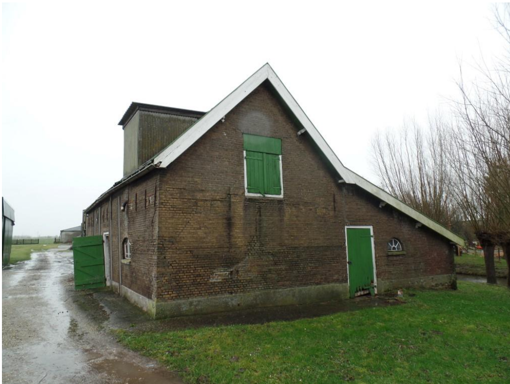
Figuur 6: De af te breken stal. Bovenin de gevel het luik dat toegang biedt tot de zolder.
