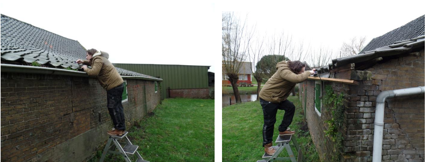
Figuur 18: Bouwkundige inspectie van het pannendak van de af te breken stal.
