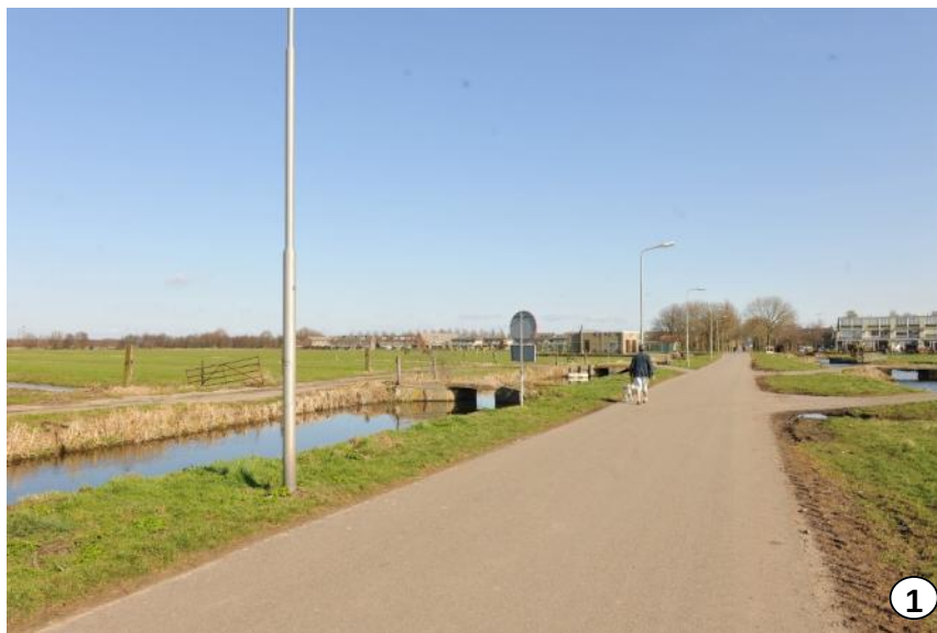
Verrommeling (bruggen / pad / woningenrand). Het ontbreken van bomen langs de Tiendweg legt meer nadruk op de lichtmasten en de relatief brede bermen voor de karakteristieke Tiendweg.
