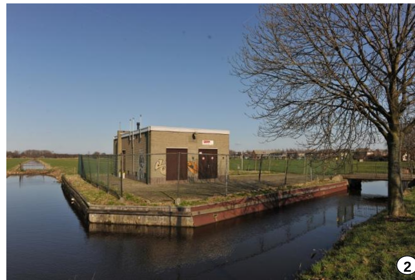
Trafo vormt ontsierende unit op een prominente locatie.
