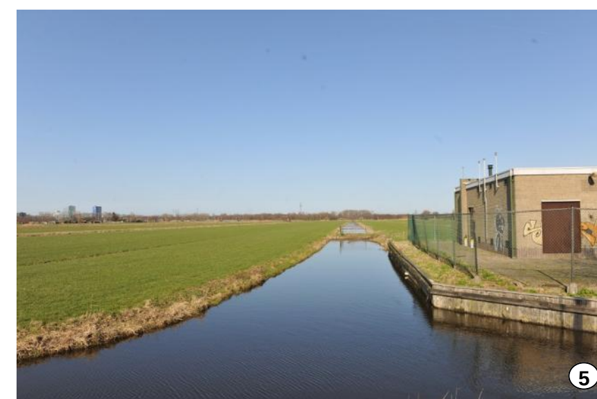
Trafo in open polder landschap met harde gebiedsvreemde oevers.
