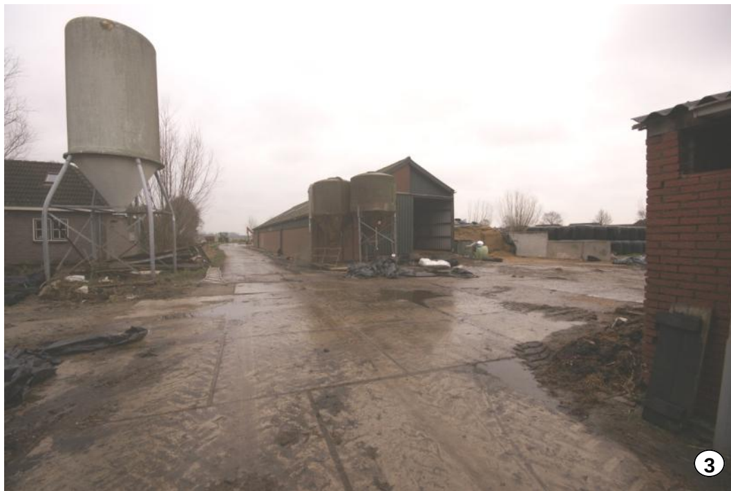
Terrein achter ligboxenstal met jongveestal en voederkuilen
