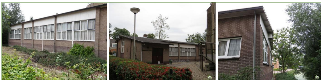
Figuur 2. Het Baken, noord oostgevel
