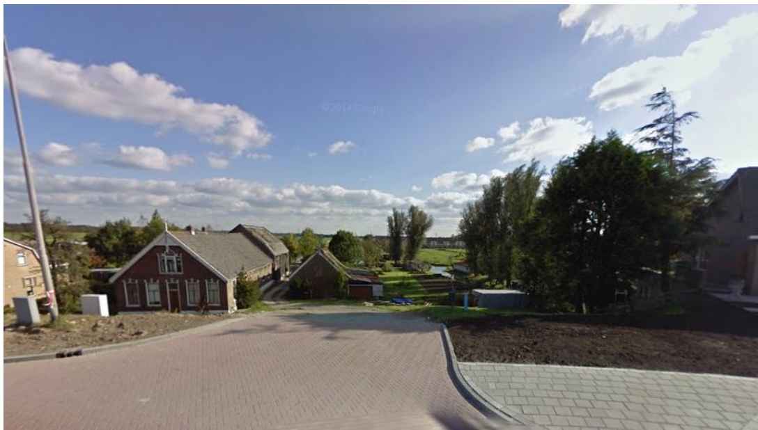
Figuur 6 oorspronkelijke situatie van voor de sloop aan de Dijk
