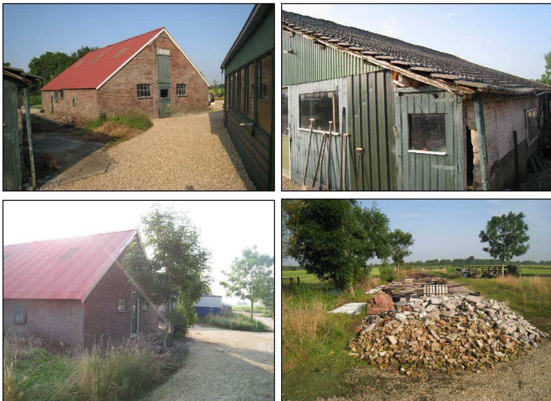
Vervolg figuur 3. Aanzicht van de te slopen opstallen Achterbroek 89 te Berkenwoude (rechtsonder: uiterst noordelijke reeds gesloopte gebouw).
