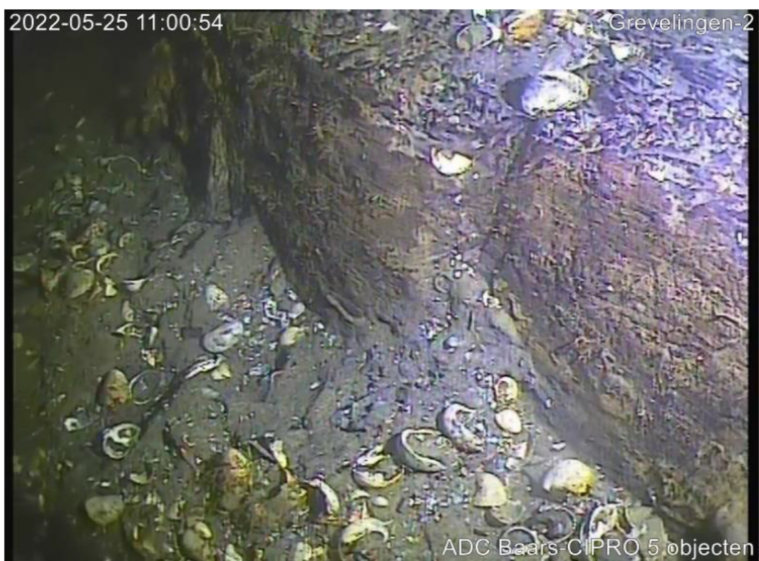
Afb. 5.6. Schuine las op houten balk GR-2.
