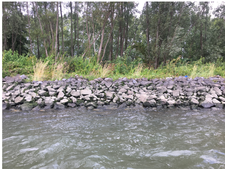
Figuur 2.4. De oever van de Oude Maas in het plangebied ter hoogte van dwarsprofiel DP-08 bij Hoogvliet. Op de oever is de steenbestorting te zien waarop de tijdelijke werkstrook wordt aangelegd.
