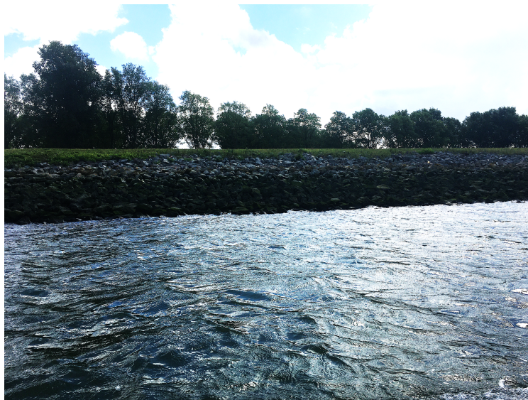
Figuur 2.6. De oever van het Hartelkanaal in het plangebied ter hoogte van dwarsprofiel DP-01H bij Spijkenisse. Op de oever is de steenbestorting te zien waarop de tijdelijke werkstrook wordt aangelegd.
