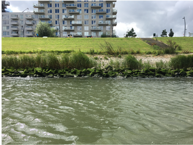
Figuur 2.5. De oever van de Oude Maas in het plangebied ter hoogte van dwarsprofiel DP-06 bij Spijkenisse. Op de oever is de steenbestorting te zien waarop de tijdelijke werkstrook wordt aangelegd.
