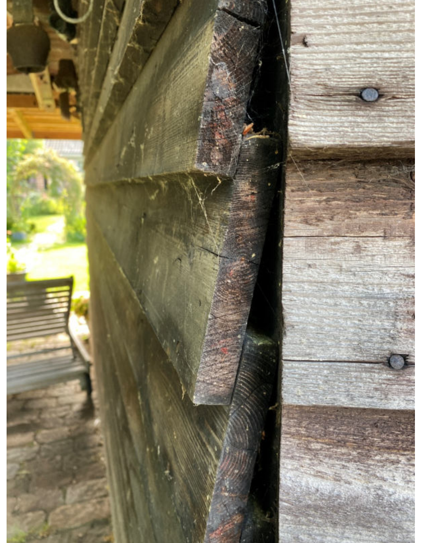
Figuur 18. Er zijn diverse openingen aanwezig waar vleermuizen in kunnen kruipen.
