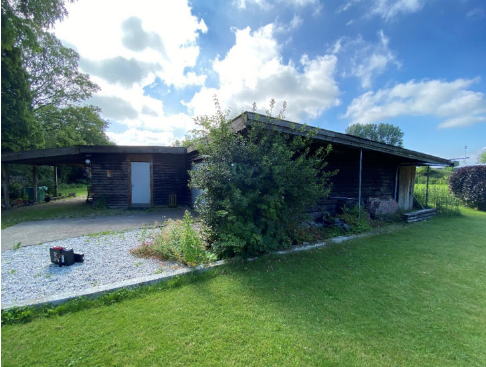
Figuur 17. De schuur zal voorlopig behouden blijven.
