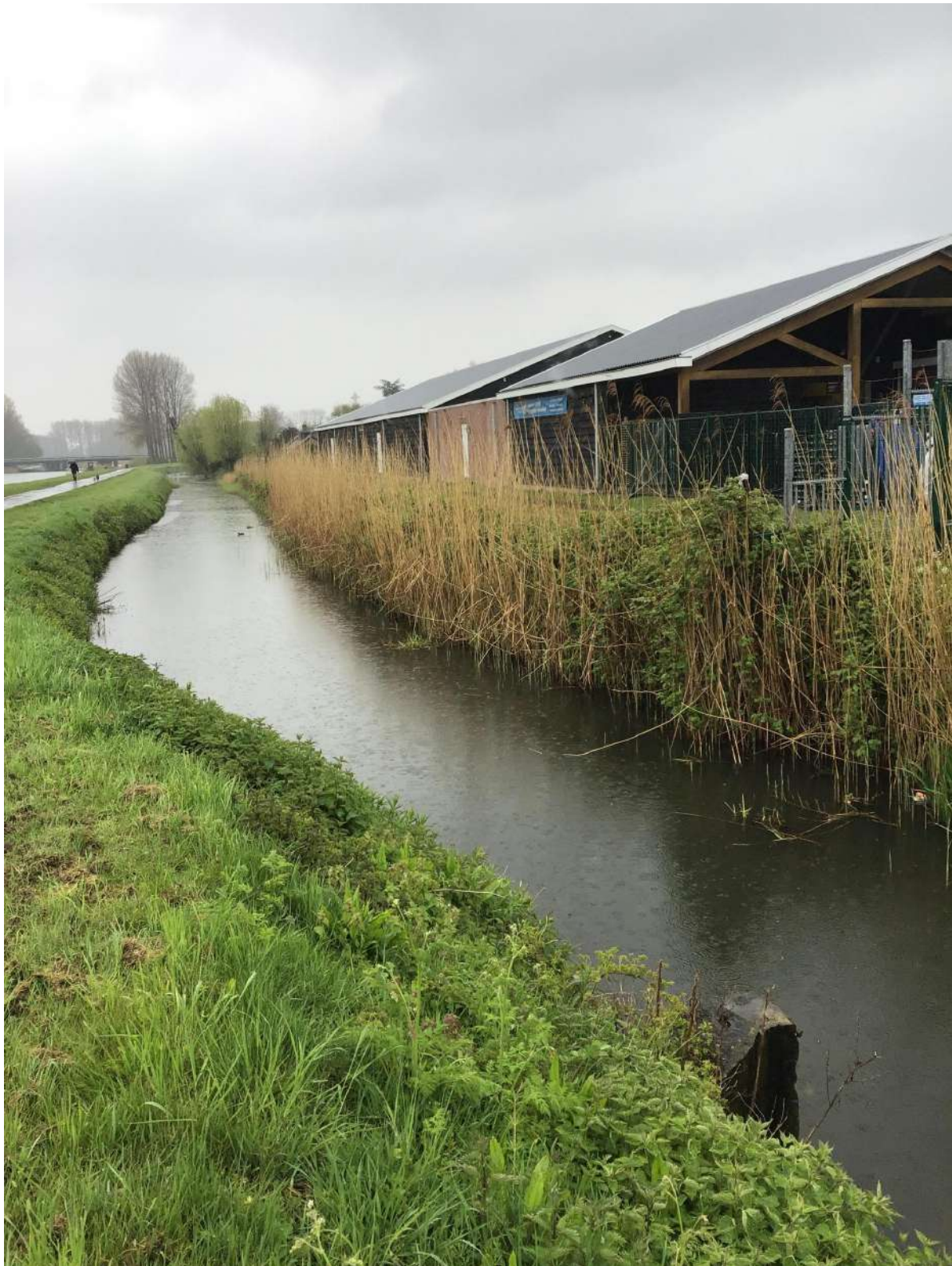
Afbeelding 60: Overzicht oever naast het pand.
