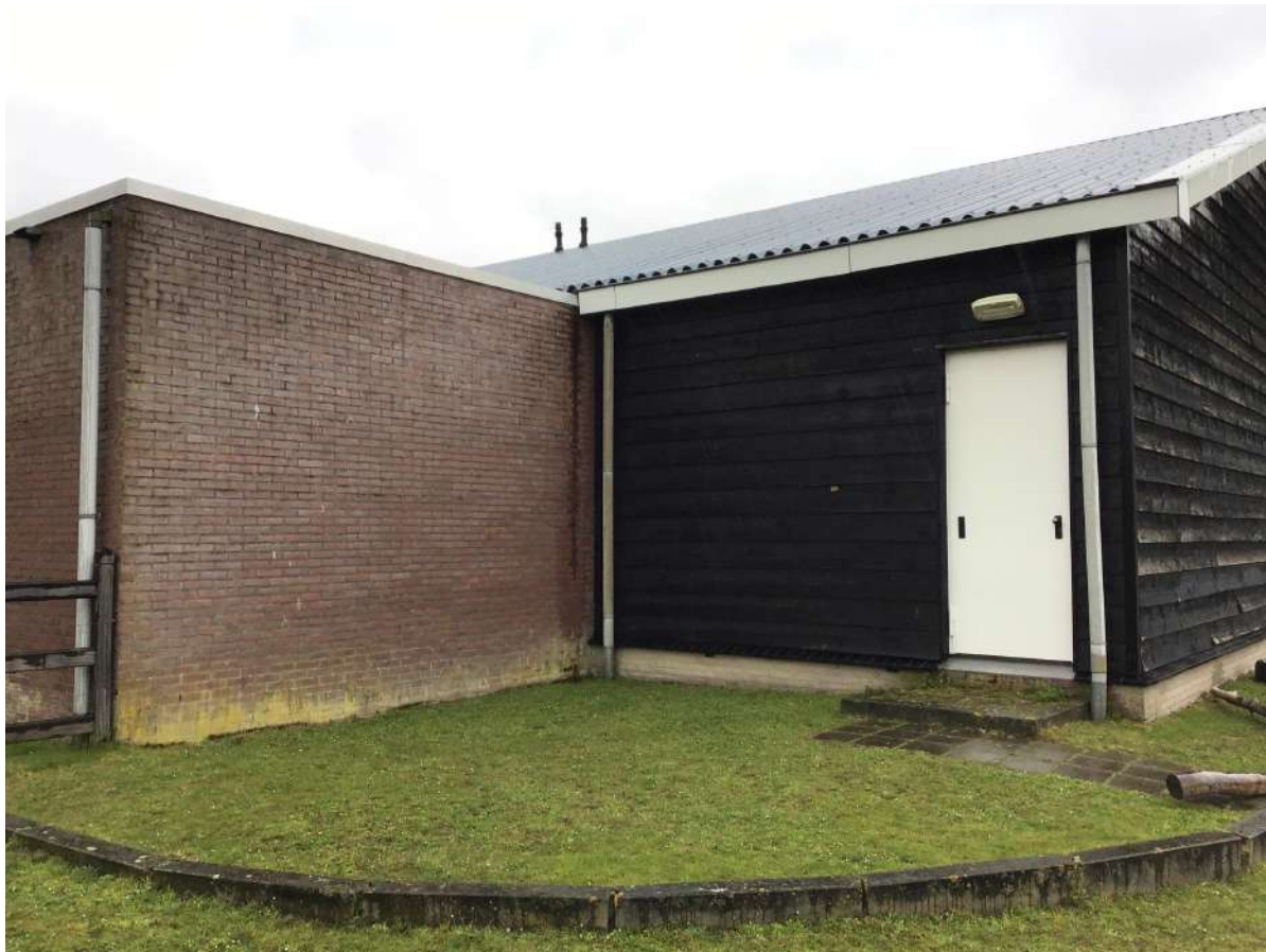
Afbeelding 28: Zuid-westhoek met stenen muur met stootvoegen en rabatdelen.
