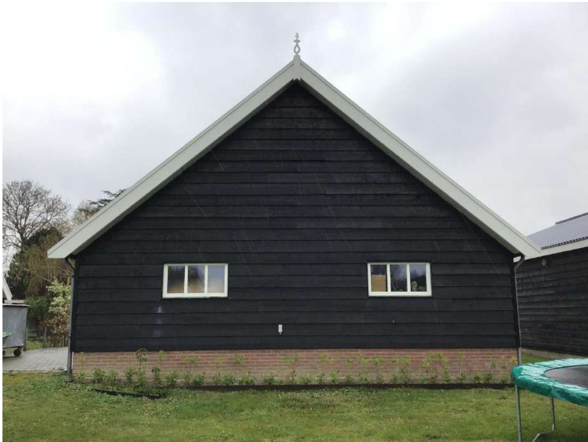
Afbeelding 36: Overzicht zuidgevel schuur.
