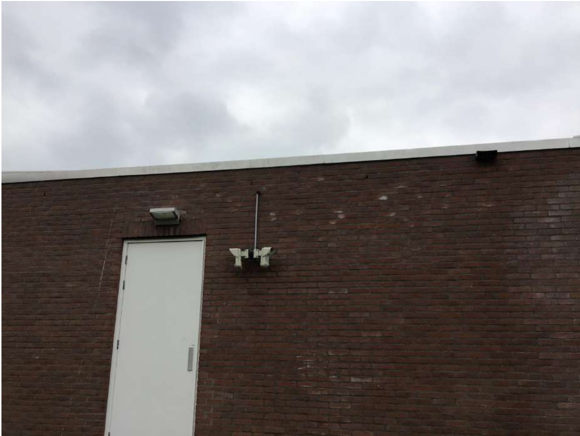
Afbeelding 18: Stootvoegen aan de oostgevel.
