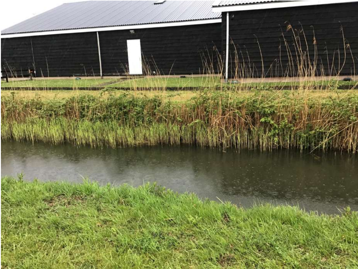
Afbeelding 64: Beschutting aan de oever langs het pand.
