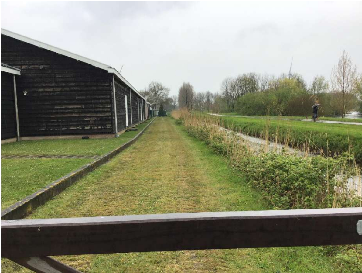
Afbeelding 57: Overzicht landstrook langs het pand (zuidperspectief).
