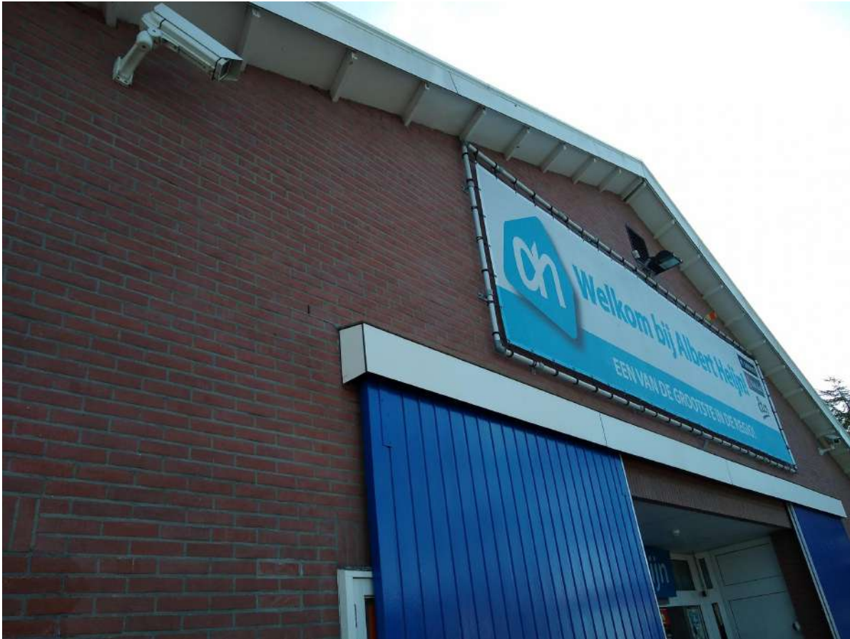
Afbeelding 5: Dakrand aan de noordgevel.
