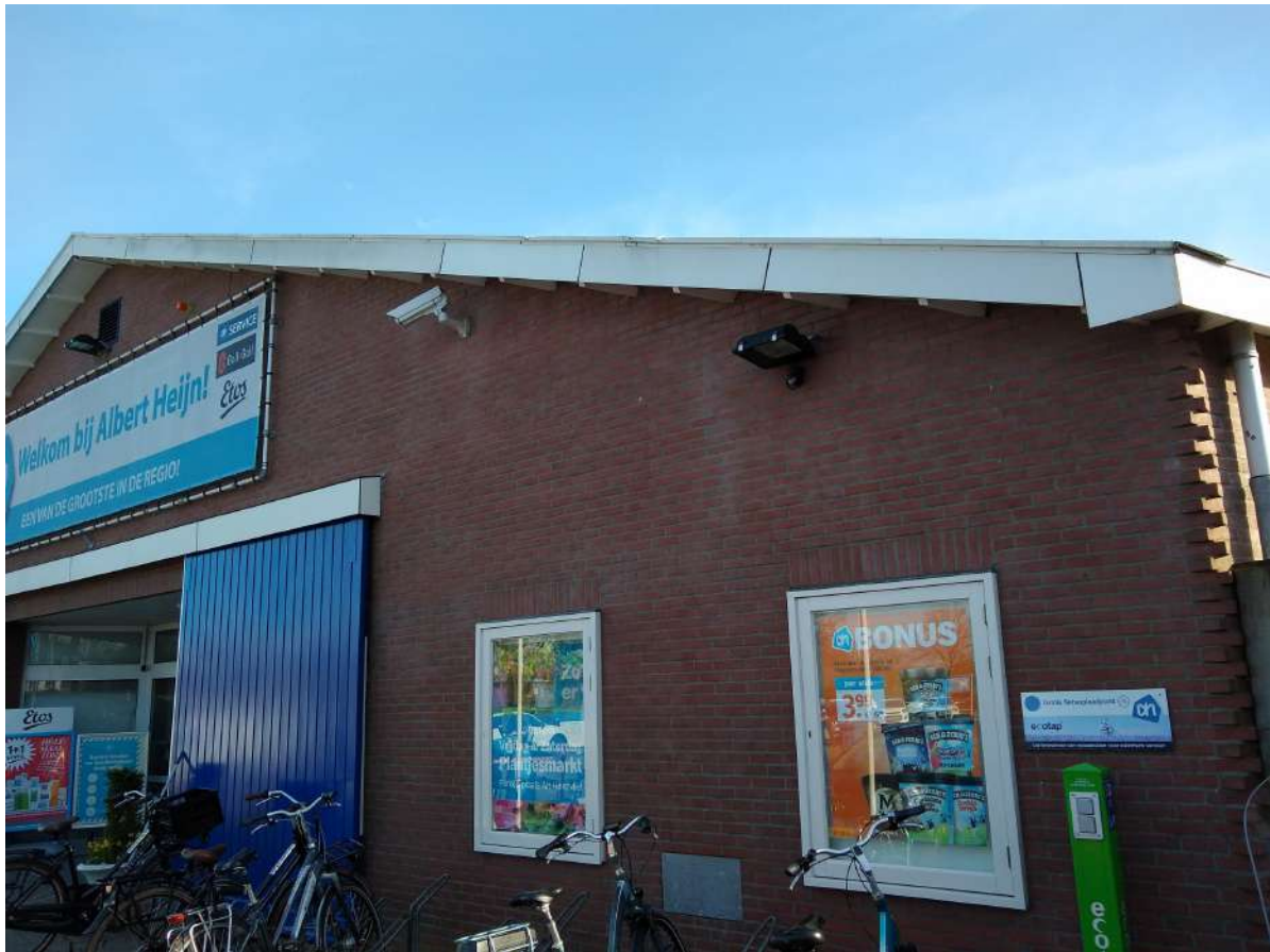
Afbeelding 6: Dakrand aan de noordgevel.
