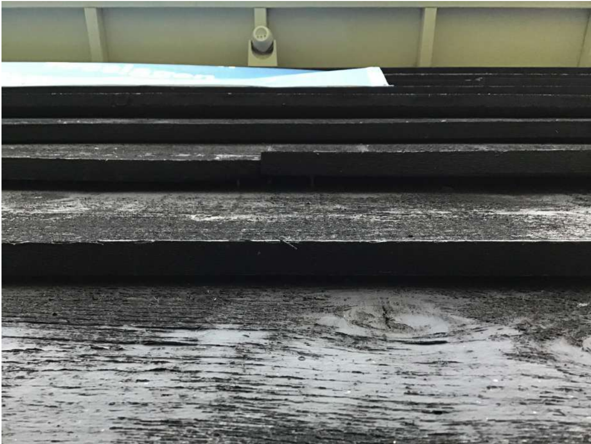
Afbeelding 16: Lossen houtplanken aan de oostgevel.
