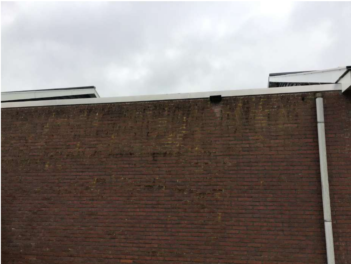
Afbeelding 30: Stootvoegen aan de westgevel
