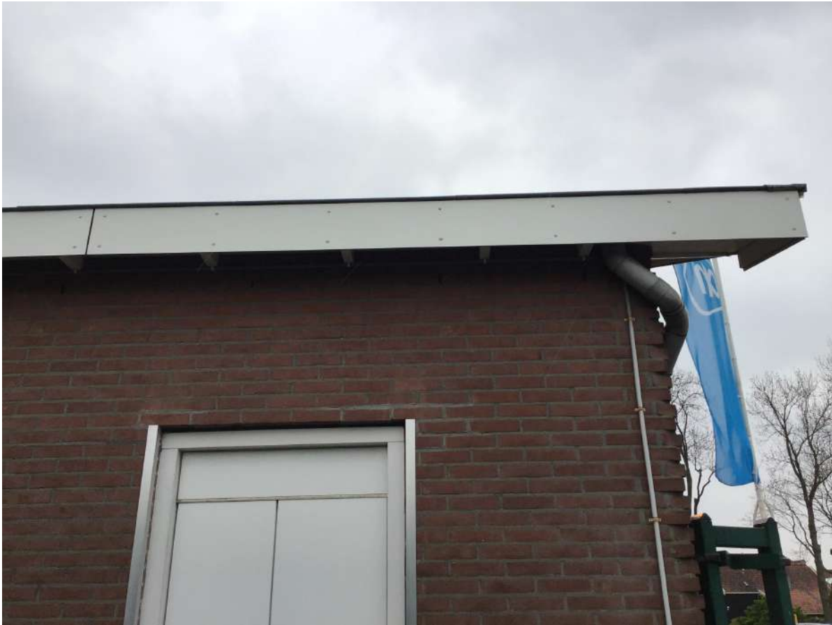
Afbeelding 9: Dakrand met eronder stootvoegen aan de oostgevel.
