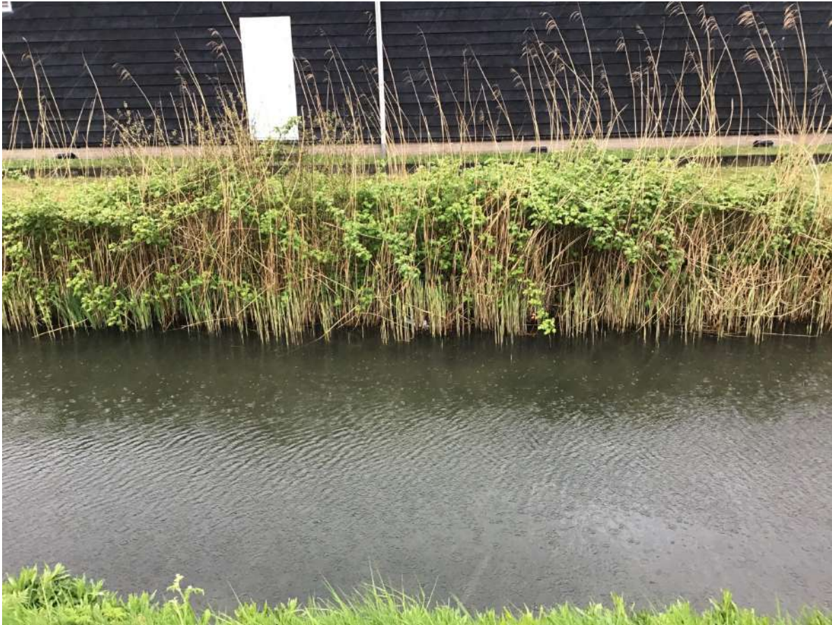
Afbeelding 63: Beschutting aan de oever langs het pand.
