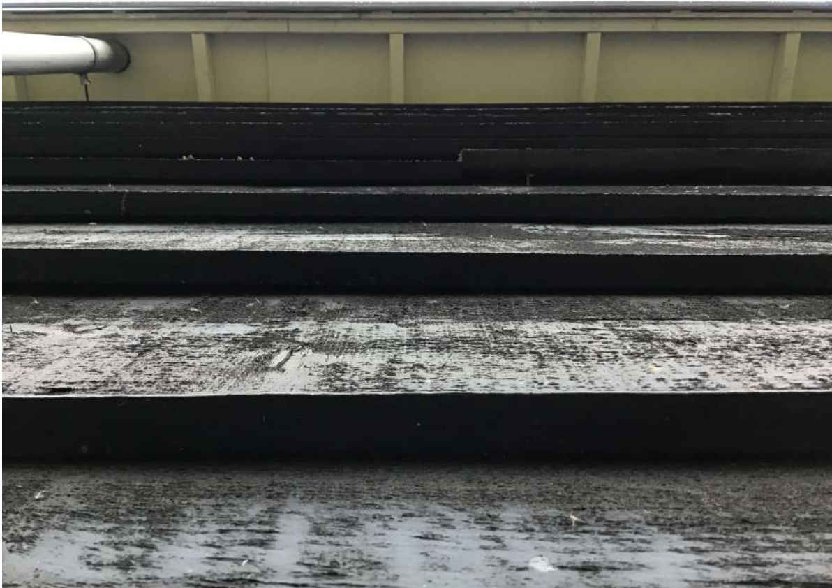
Afbeelding 19: Lossen houtplanken aan de oostgevel.
