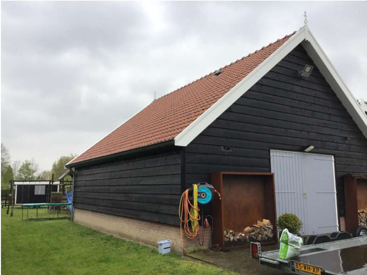
Afbeelding 34: Overzicht noord en oostgevel schuur met mogelijk ruimte achter het schoorsteentje en onder de nok.
