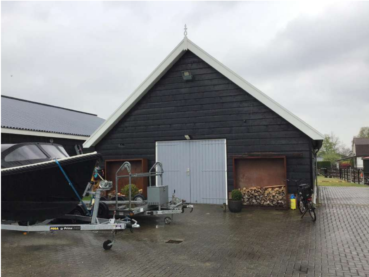
Afbeelding 33: Overzicht noordgevel schuur.
