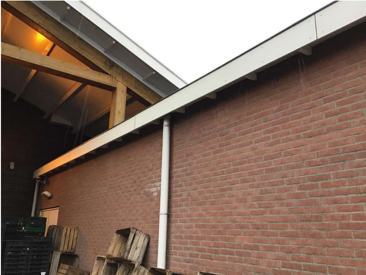
Afbeelding 10: Dakrand met eronder stootvoegen aan de oostgevel.
