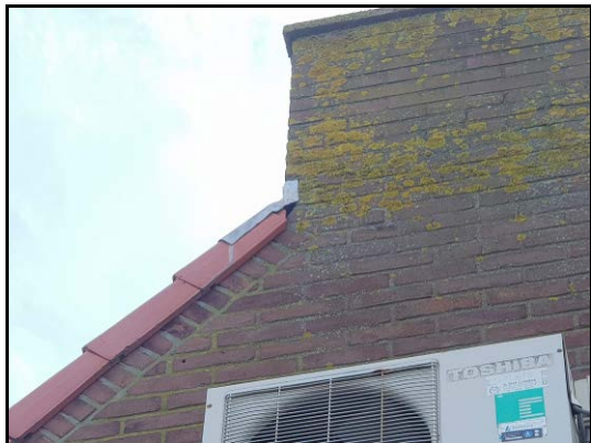
Afbeelding 4: Ruimte onder loodflap
