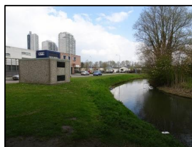
Figuur 9. Watergang ter hoogte van de Theemsweg waar voornemens de toegangsweg wordt gerealiseerd met beschoeide kades (kijkrichting naar het noorden).
