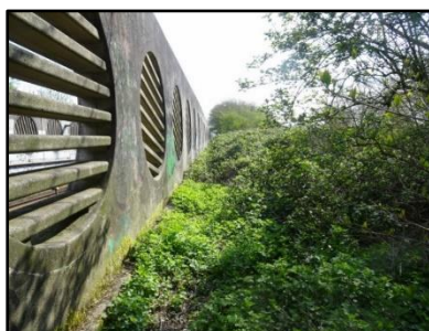
Figuur 10. Zuidelijke helft van de bosschage aan de zuidkant van de metrobak (kijkrichting naar het oosten).
