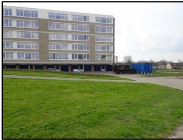
Figuur 15. Flatgebouw gelegen ten zuiden van de onderzoekslocatie (kijkrichting naar het zuiden).
