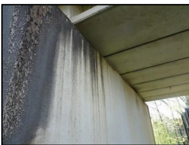
Figuur 19. Zicht op onderzijde van het metroviaduct. Zichtbaar zijn openingen boven de draagmuur en tussen de betonplaten.
