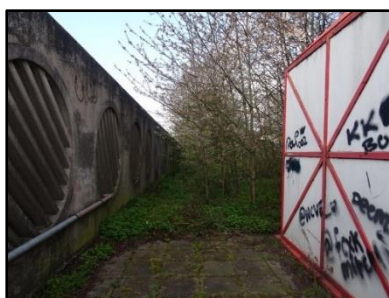
Figuur 3. Zicht op de noordelijke bosschage ten noorden van de metrobak (kijkrichting naar het westen).
