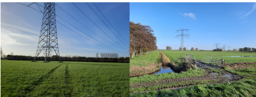
Figuur 3.2 Mast 066 (links) en mast 067 (rechts).
