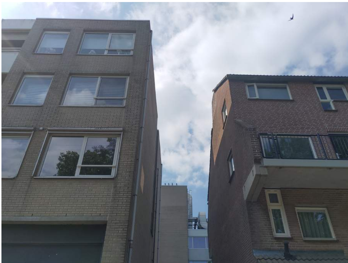
Tijdens het verkennend veldbezoek vlogen gierzwaluwen laag over de woonhuizen aan de J.C. Sterrenburgstraat, wat kan duiden op de aanwezigheid van vaste rust- en verblijfplaatsen in deze bebouwing. Rechts bovenin is een laag overvliegende gierzwaluw te zien (rood omcirkeld). Foto: M.J.A. van der Neut | Ecoresult B.V.
