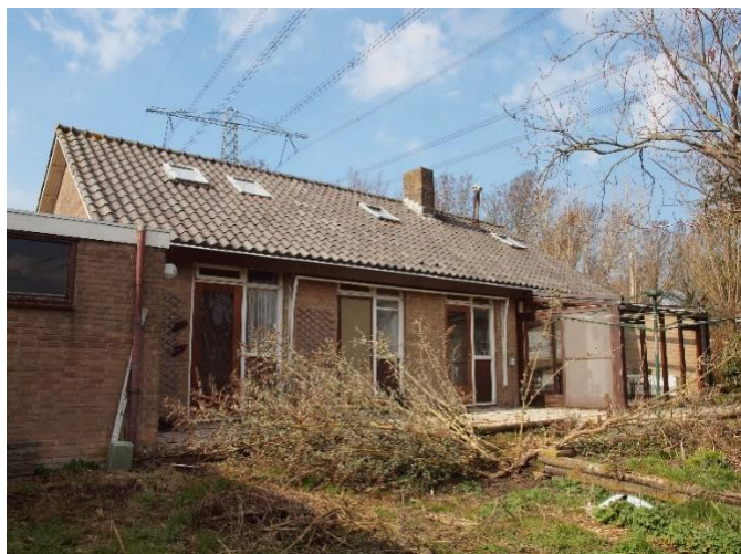
Figuur 4. De verwilderde achtertuin bij de woning.
