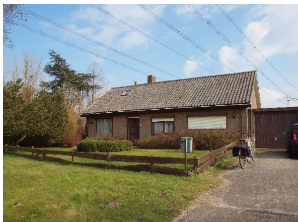
Figuur 2. Aanzicht voorzijde woning vanaf de Oudelandsedijk.
