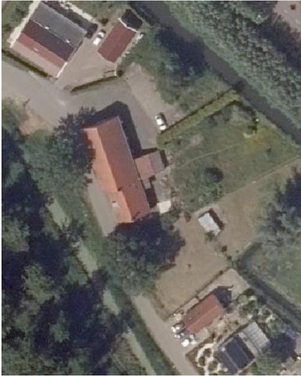
Figuur 2.1: luchtfoto perceel
