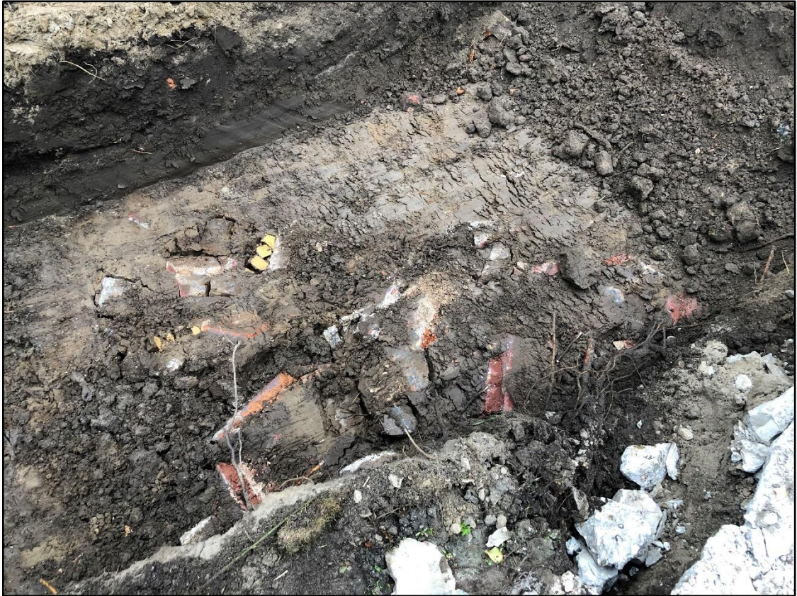
Figuur 2. Tijdens de aanleg van de werkputten kwam veel puin tevoorschijn, voornamelijk bakstenen.
