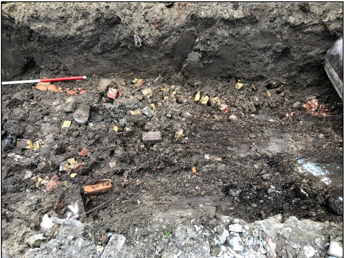
Figuur 3. Nog meer puin tijdens de aanleg.
