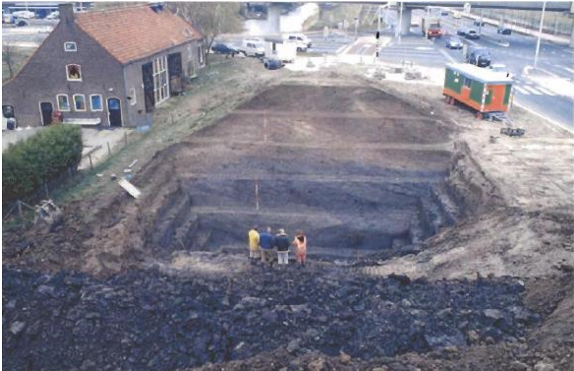
Figuur 2: Foto van de dwarsdoorsnede van de Lange Schenkeldijk (Burnier en Houkes, 2003).
