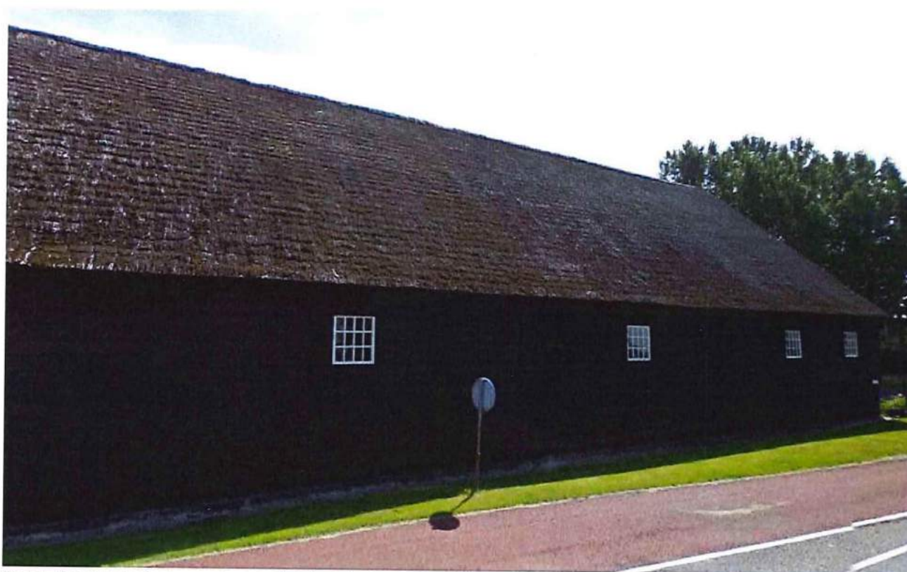
Bestaande bebouwing in de omgeving; gevels in hout; donkere dakbedekking
