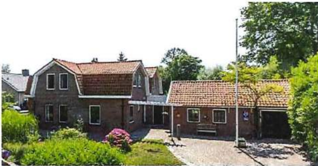
Bestaande bebouwing in de omgeving: gevels in metselwerk
