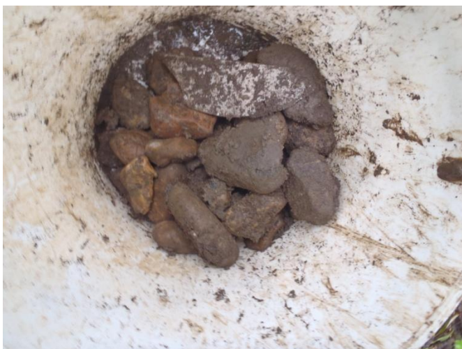
Foto 29: uitgezeefd puin inspectiegat A12
