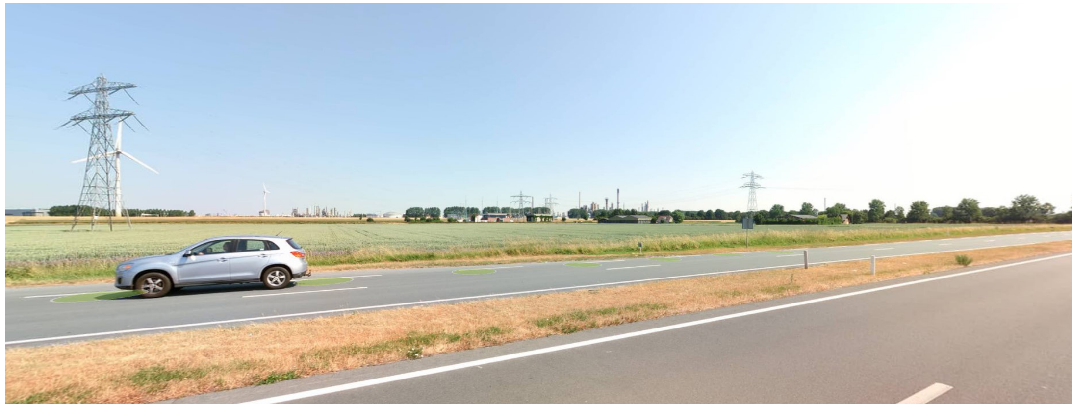
Zicht op hoogspanningsstation vanaf provinciale weg N218 (Groene Kruisweg), kijkend in noordoostelijke richting
