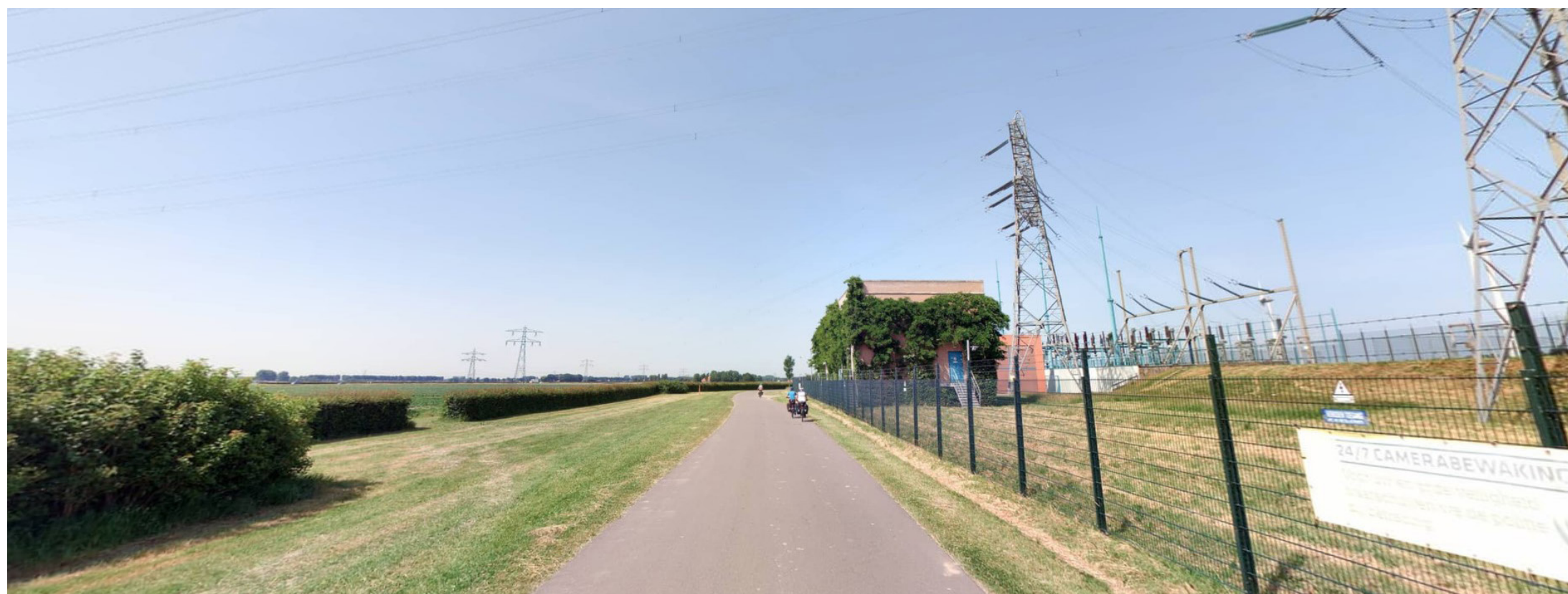
Noorddijk Geervliet, kijkend in westelijke richting ter hoogte van vakwerkmast en gebouw TenneT. Zicht op open poldergebied.
