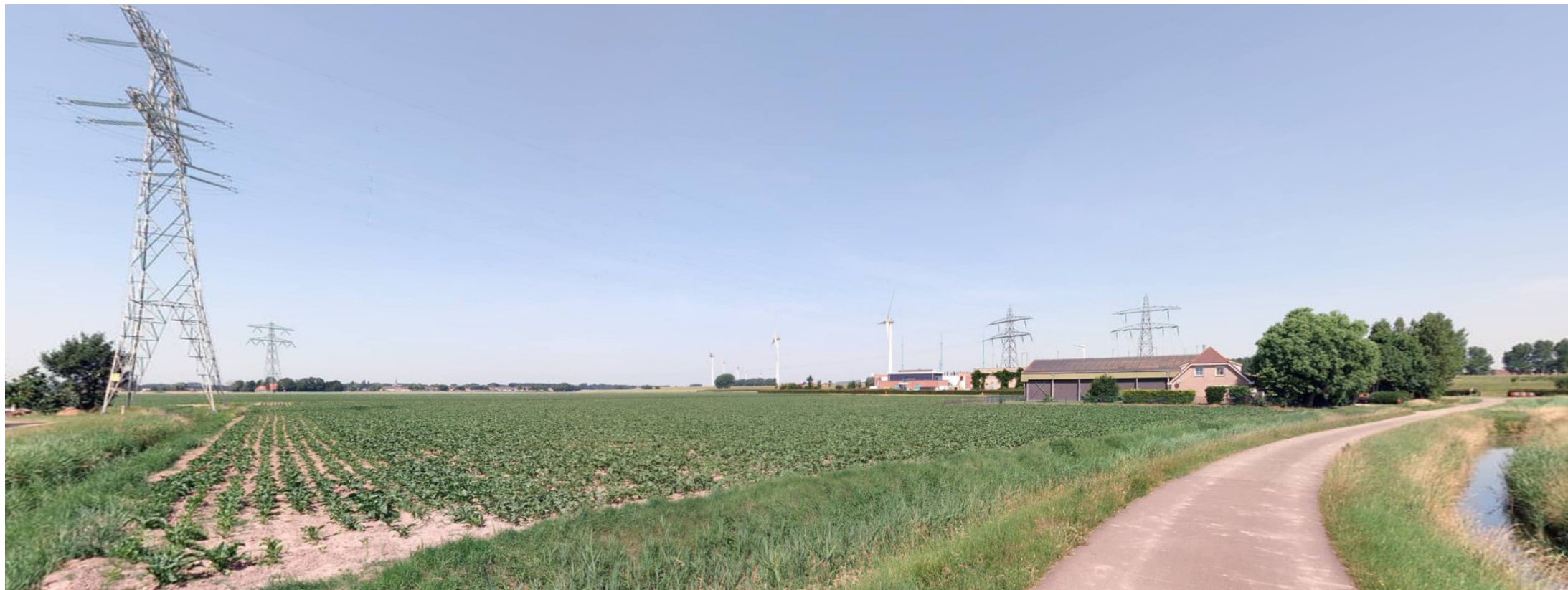
Hogelandseweg 20, kijkend in noordwestelijke richting. Zicht op gebouwen en vakwerkmasten hoogspanningsstation en gebouwen en boombeplanting Hogelandseweg 18.
