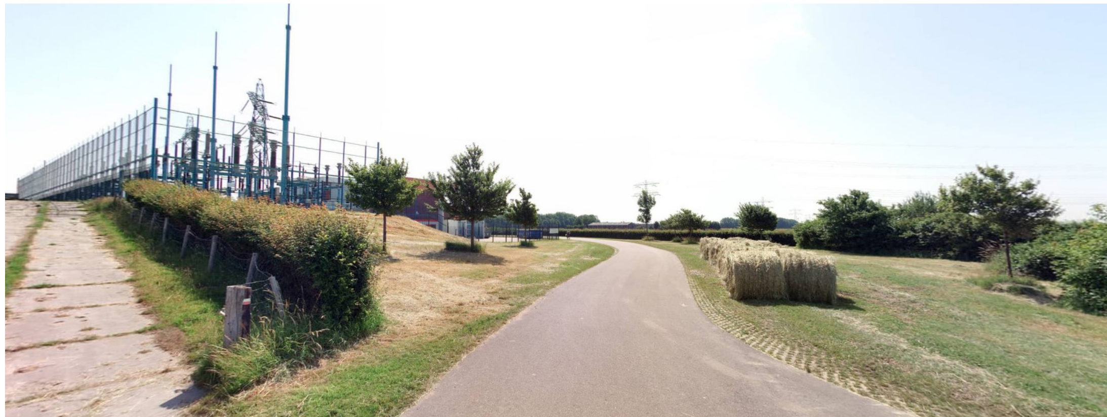
Noorddijk Geervliet, kijkend in oostelijke richting. Zicht op westelijke zijde hoogspanningsstation en groene binnenruimte met bomen, struiken en natuurlijk grasland
