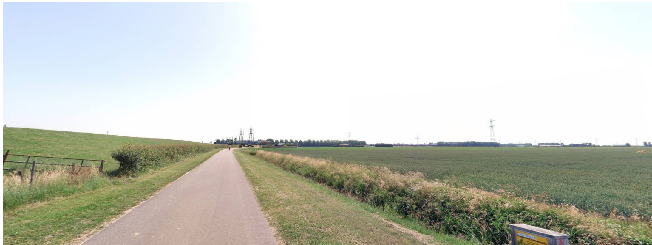
Noorddijk Geervliet, kijkend in oostelijke richting vanaf begin begeleidende haag langs regionale kering
