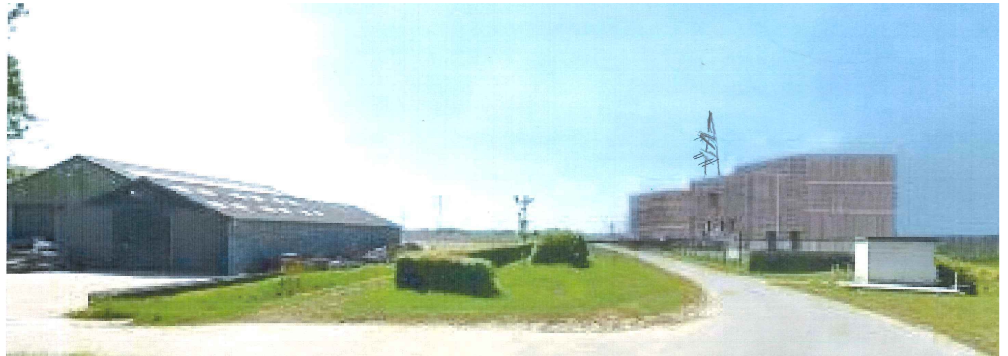
zicht op nieuw gis gebouw /bestaand gebouw vanaf kruising Noorddijk/hogelandseweg in westelijke kijkrichting met behoud westelijke vakwerkmast
