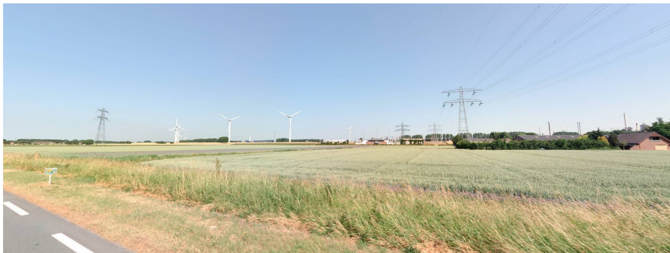
Zicht op hoogspanningsstation vanaf provinciale weg N218 (Groene Kruisweg), na kruising Hogelandseweg, kijkend in noordwestelijke richting met rechts bebouwing Hogelandseweg
