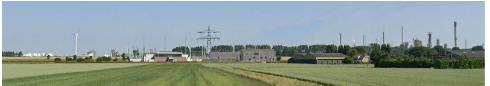
zicht op hoogspanningsstation vanaf provinciale weg N218 met behoud westelijke vakwerkmast
