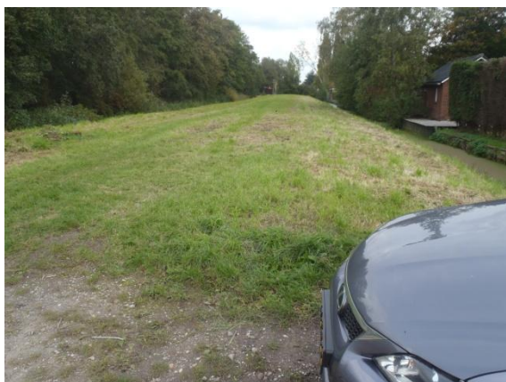
Foto 1: locatie voormalige trambaan (gedeelte op fase 1 t/m 3)
