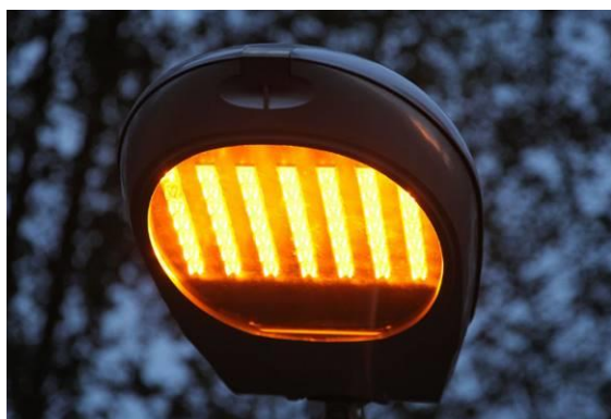
Figuur 5.2. Links: amberkleurige UV-vrije LED-armatuur. Rechts: scherpe afsnede van lichtinval.
