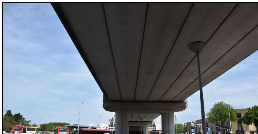
Figuur: langs het plangebied loopt een trambrug. In deze brug zijn diverse spleetvormige ruimtes aanwezig. Vleermuizen kunnen hier verblijfplaatsen hebben.
