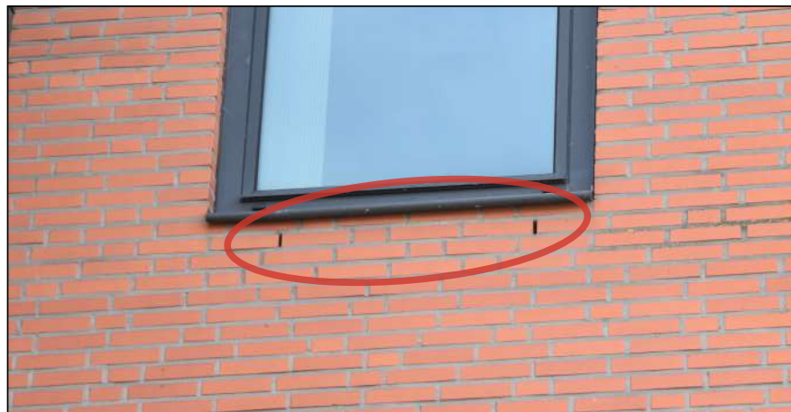
Figuur: detailopname van de woontoren. Via de aanwezige open stootvoegen kunnen vleermuizen de spouw bereiken waar ze verblijfplaatsen kunnen hebben.
