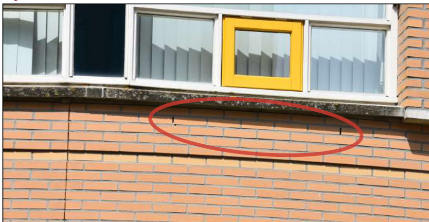
Figuur: ook in de naastgelegen zorginstelling zijn open stootvoegen aanwezig. Vleermuizen kunnen via deze openingen de spouw bereiken waar ze verblijfplaatsen kunnen hebben.
