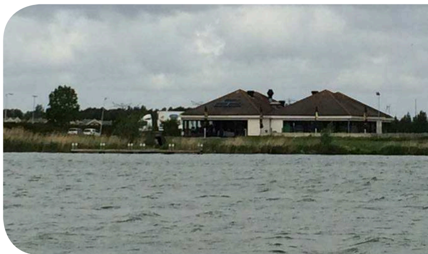
figuur 8. bestaande steiger bij de Pannekoekenbakker
