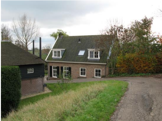
Oprit vanaf Sluis naar de woning Sluis 72.
