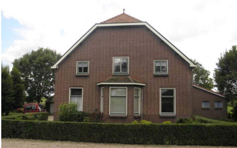
De voorgevel van de boerderij aan de Hofwegen 5 met wolfseind en erker. Op de foto is rechts de aanbouw uit de jaren 70 te zien.
