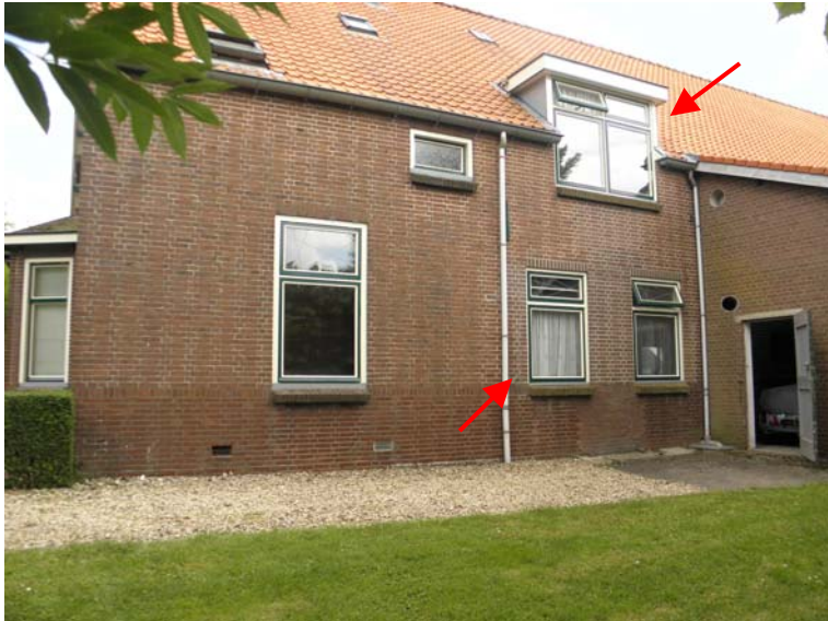
Op de foto een deel van de rechter zijgevel. Op deze foto is te zien dat ter plaatse van het voormalige hooiluik en de staldeur een dakkapel en twee vensters zijn toegevoegd. (rode pijlen)
