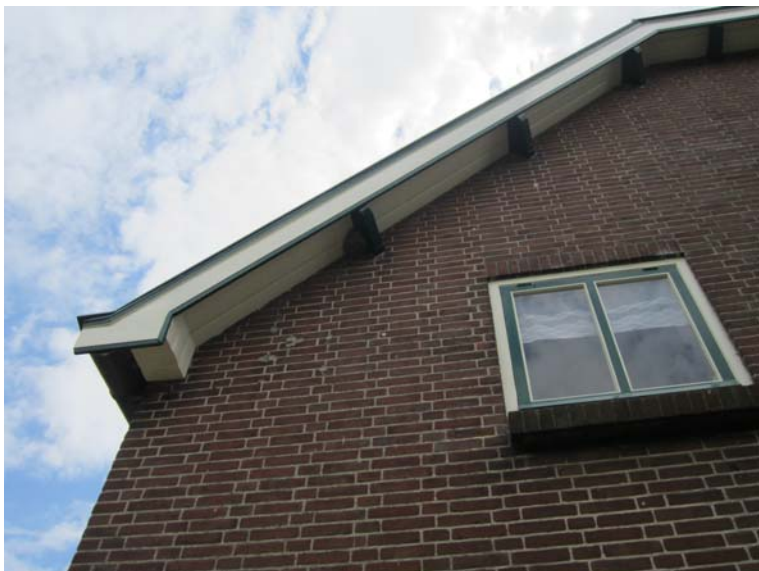
Aan de bovenzijde wordt de gevel beëindigd door een eenvoudige, maar subtiel gedetailleerde windveer. Onder de windveer zijn, in dezelfde stijl als de gootklossen van de erker, de gordingen/ gootklossen te zien.
