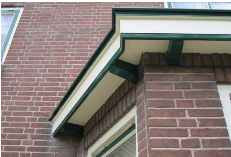
De bovenzijde van de erker met de gootklossen en de rollaag boven de kozijnen.
