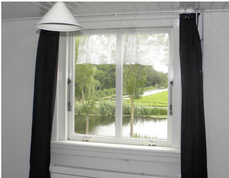
De kozijnen en vensterbank op de begane grond en verdieping dateren uit de originele bouwfase.
