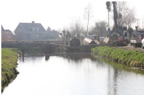
Gemaal Liesveld-Graafland (in aanbouw)
