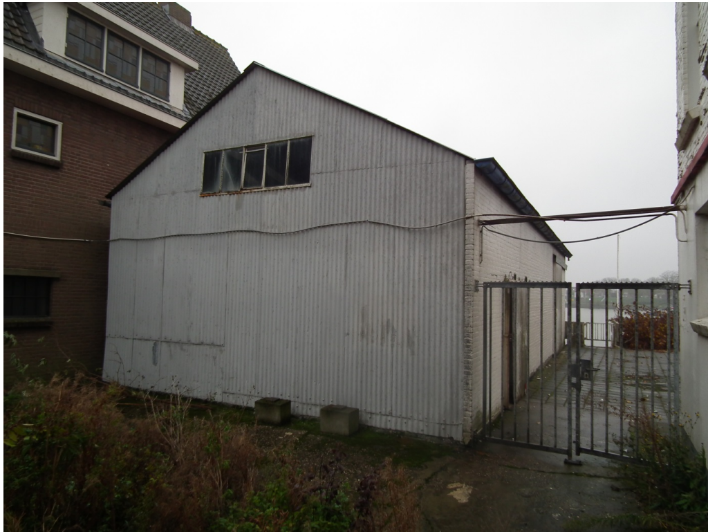
Figuur 3 De heer Valckenier is voornemens de lood te slopen en het kantoorpand te herontwikkelen tot bebouwing met een maatschappelijke of zorgfunctie.
