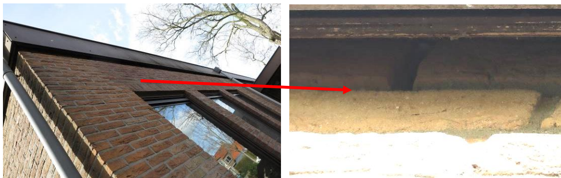
Figuur 8. Foto-impressie van potentiële verblijfplaatsen van vleermuizen in het Dorpshuis 't Trefpunt te Oud-Alblas.
