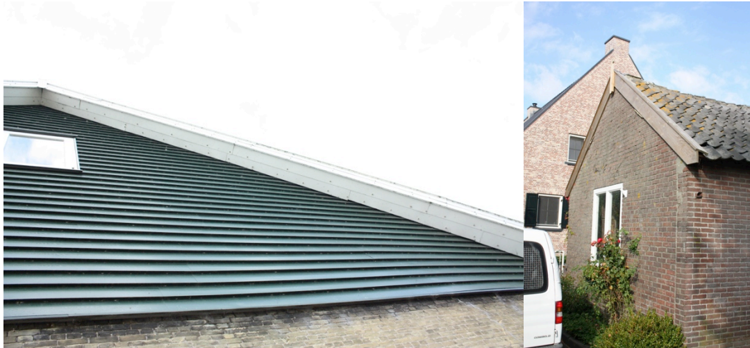
Figuur 1 Achterzijde van de aan het woonhuis gebouwde schuur (links) en bijgebouw (rechts).
