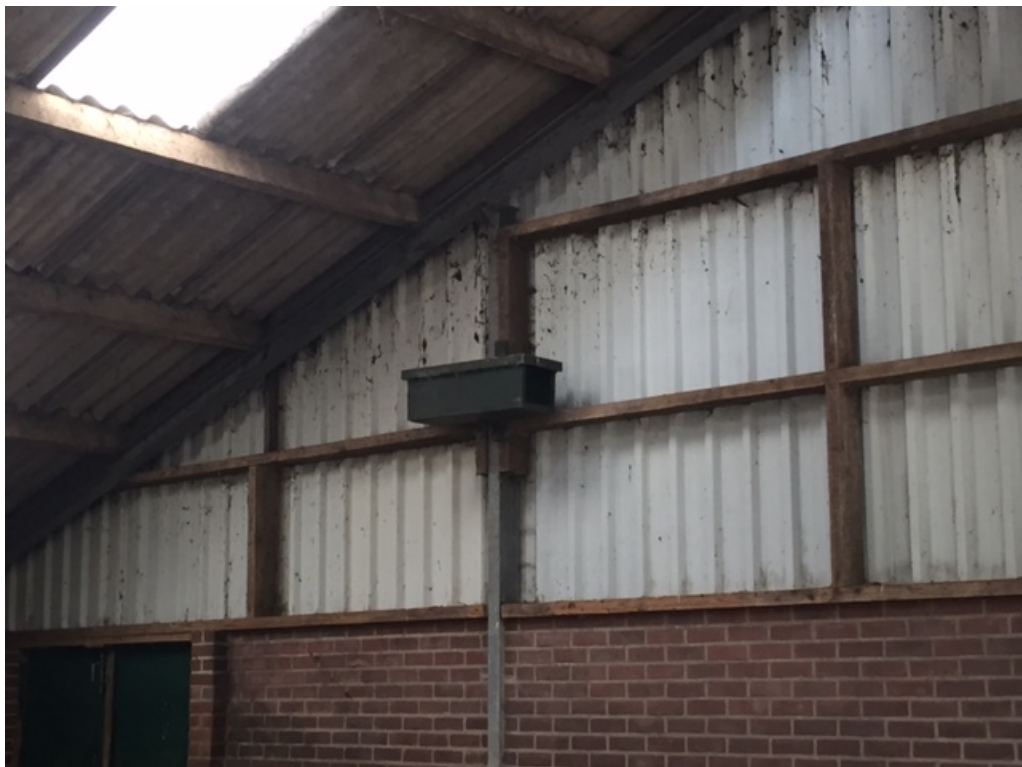
Figuur 4 Aan de binnenzijde van de ligboxenstal, tegen de noordgevel is een steenuilkast gemonteerd. De kast wordt gebruikt door een paartje steenuilen.
