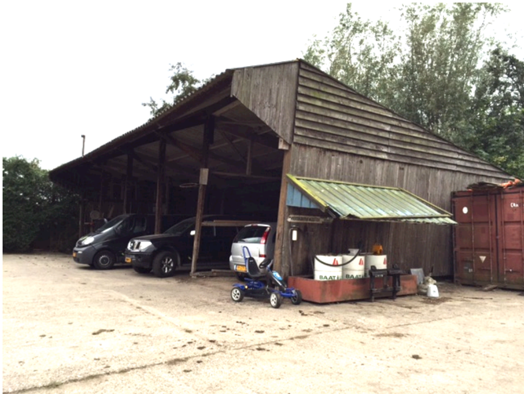
Figuur 3 De kapschuur naast de woning wordt gebruik als stalling van auto's en allerlei materialen. De schuur wordt gesloopt ten behoeve van de te realiseren woning
