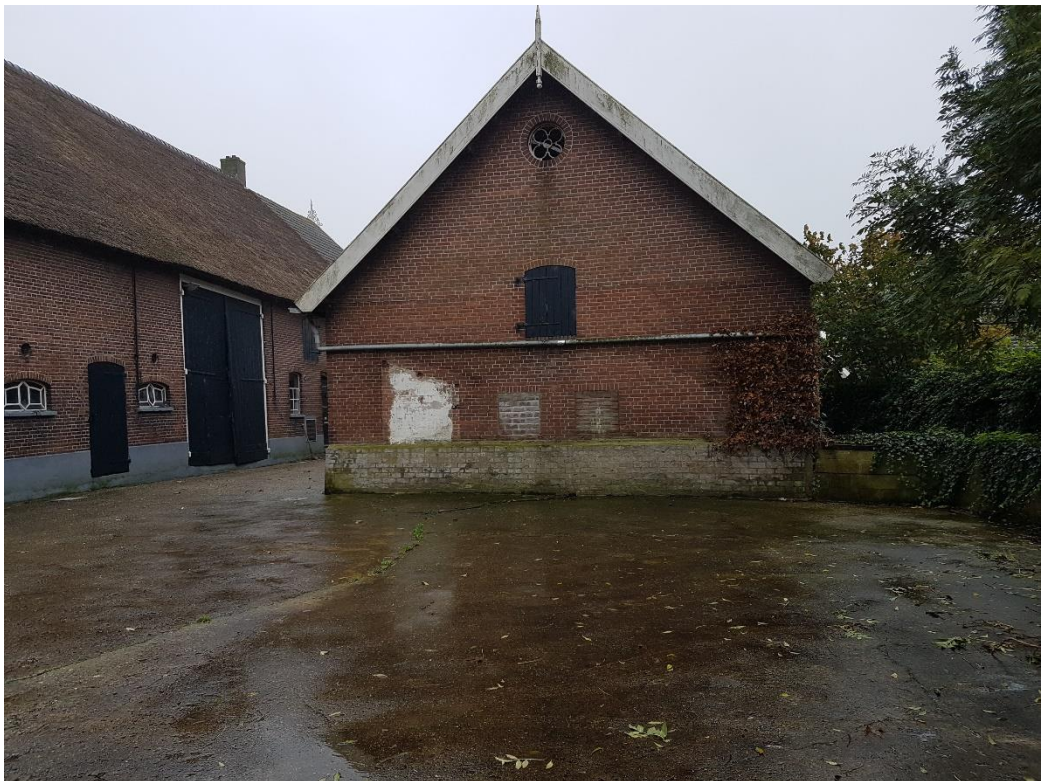
Figuur 4 Bijgebouw aan de westzijde van de planlocatie.
