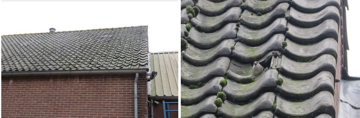
Figuur 3. Huismus in het dak in de om te vormen bebouwing aan de Noordzijde 23 te Oud-Alblas.
