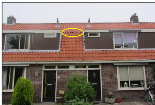
Afbeelding 2: Ruimte tussen dakpannen
