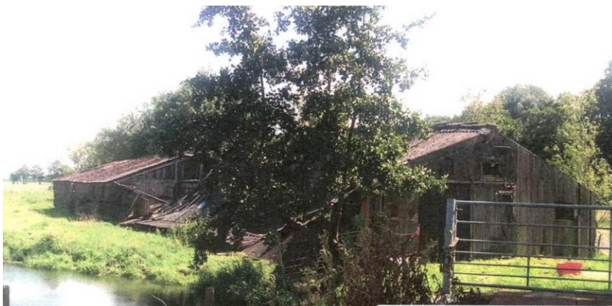
Afbeelding 4: foto (inmiddels) gesloopte schuren aan de Lekdijk 23
