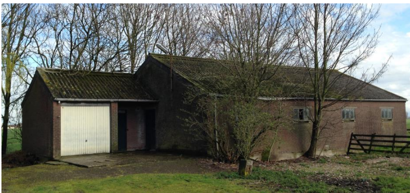
Figuur 4 voormalige stalruimte
